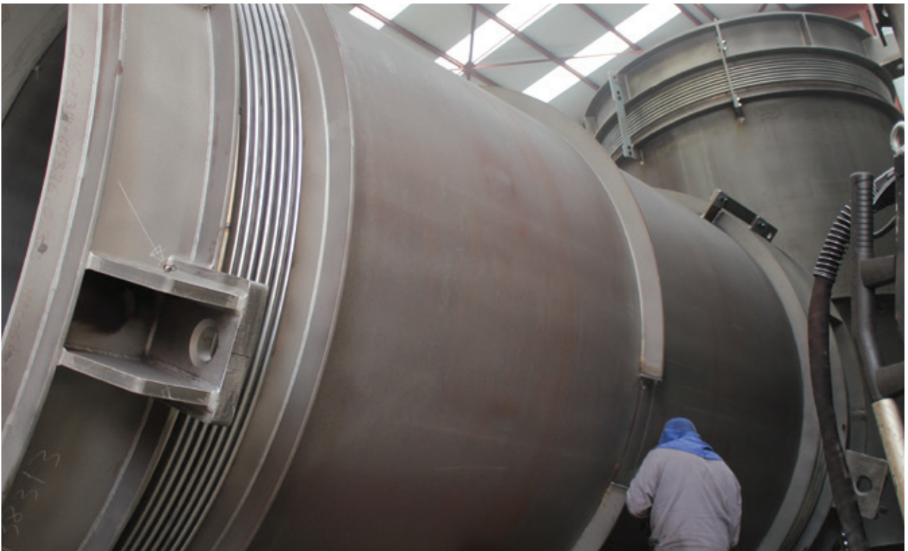
Дуговая сварка под флюсом
